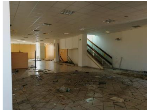
MO Celje Generator CTN: 3,6 mio EUR / 5,9 mio EUR
